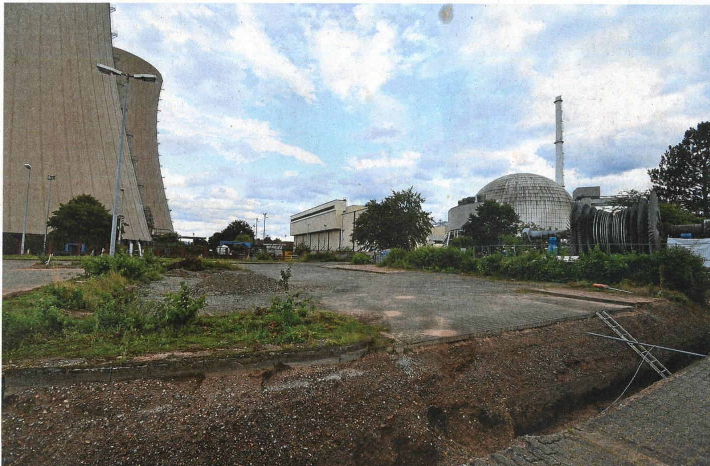
Derzeit finden sogenannte Suchschachtungen für die unterirdischen Leitungen wie für Wasser, Strom und Abwasser statt. Der Graben wird anschließend wieder aufgefüllt. Auf dem Parkplatz ist ein neues Wachgebäude vorgesehen. Weitere Einrichtungen folgen. FOTO: CB
